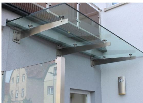
Espada ist in den Glasstärken von 12,76 bis 21,52 mm erhältlich. Je nach Dachausladung wird die entsprechende Glasstärke und Schwerterhöhe verwendet. So sind Einzelgläser bis zu einer
